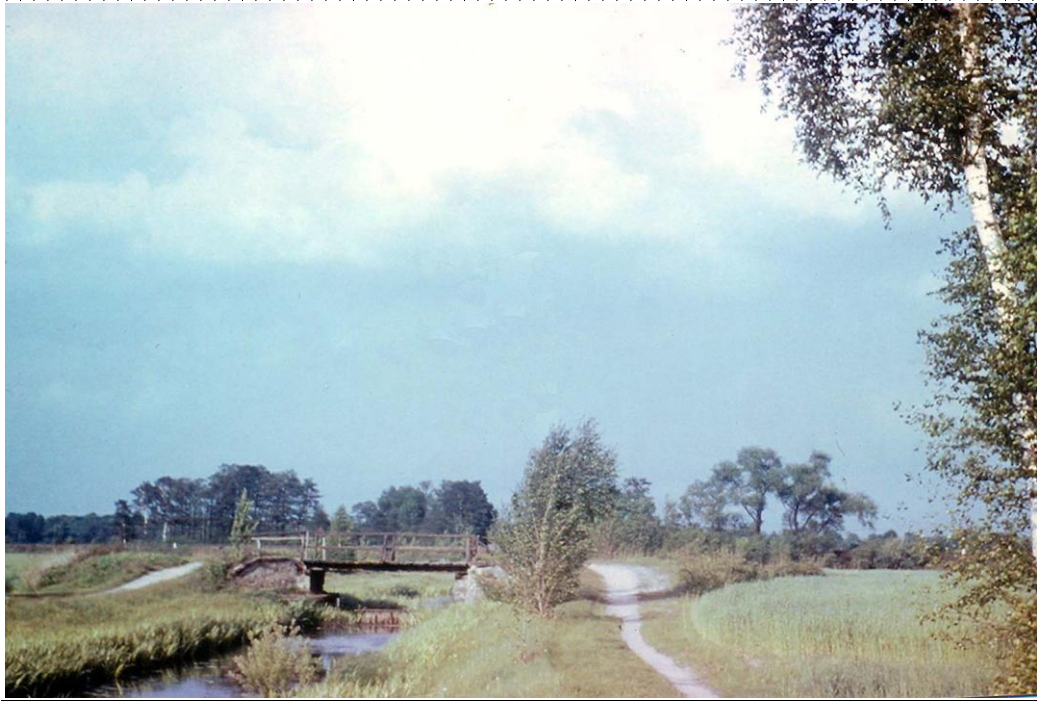
Werner Galle Aufnahme 1955: Die Floßkanalbrücke bei Kotschka
